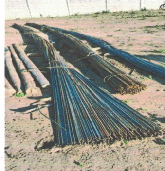
Chegada de material (vergalhão) (-9.7709817, -36.3474868) Data: 06/04/2026
