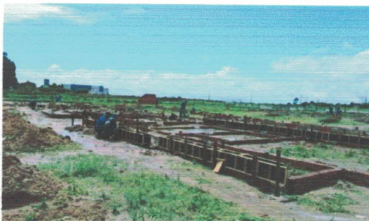
Montagem de formas e alvenaria de embasamento (-9.7709817, -36.3474868) Data: 08/05/2026
