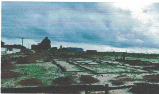
Concretagem das estacas (-9.7709817, -36.3474868) Data: 23/04/2026
