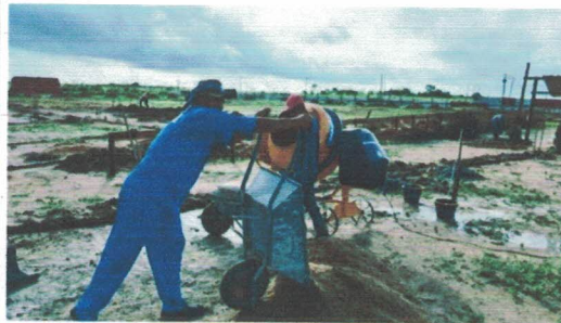
Concretagem das estacas (-9.7709817, -36.3474868) Data: 23/04/2026
