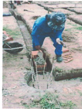
Embasamento da obra (-9.7709817, -36.3474868) Data: 27/04/2026
