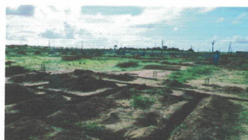
Escavação da obra (-9.7709817, -36.3474868) Data: 04/05/2026
