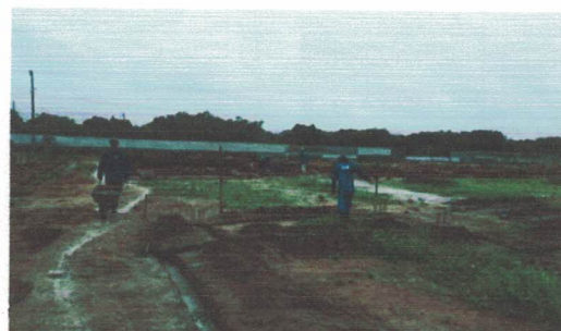
Escavação e regularização do terreno para execução (-9.7709817, -36.3474868) Data: 09/05/2026
