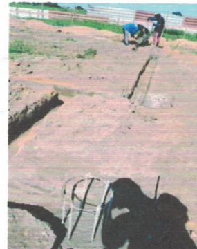
Concretagem das estacas (-9.7709817, -36.3474868) Data: 29/04/2026
