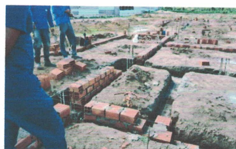
Embasamento da obra (-9.7709817, -36.3474868) Data: 30/04/2026
