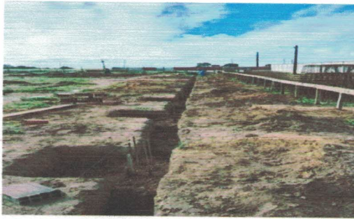
Concretagem das estacas (-9.7709817, -36.3474868) Data: 30/04/2026
