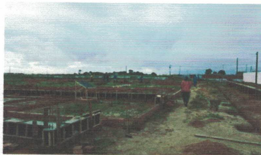
Concretagem de vigas baldrame (-9.7709817, -36.3474868) Data: 13/05/2026
