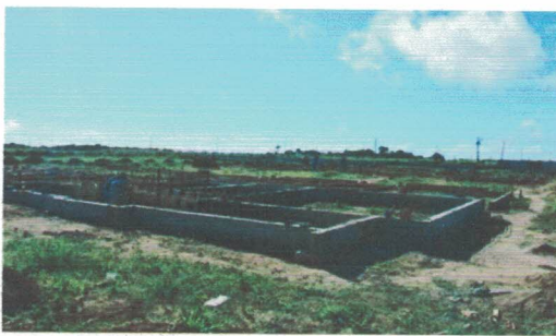
Vigas baldrame concretadas e desformadas. (-9.7709817, -36.3474868) Data: 16/05/2026
