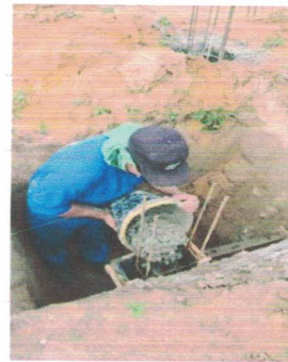
Enchimento de sapata (-9.7709817, -36.3474868) Data: 28/04/2026
