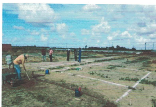
Locação da obra e escavação da fundação (-9.7709817, -36.3474868) Data: 08/04/2026
