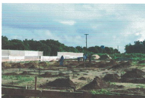
Concretagem das estacas (-9.7709817, -36.3474868) Data: 18/04/2026
