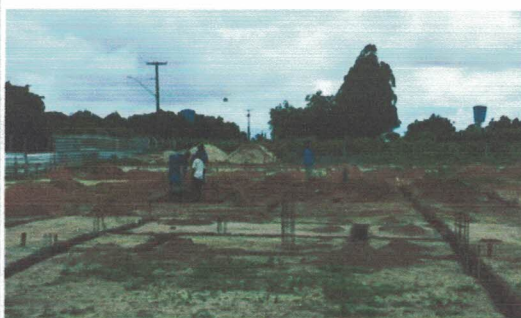
Concretagem das estacas (-9.7709817, -36.3474868) Data: 21/04/2026
