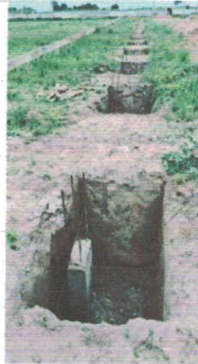
execução de sapatas isoladas e montagem das (-9.7709817, -36.3474868) Data: 06/05/2026
