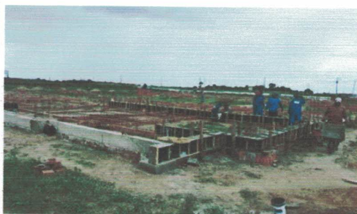
Execução de vigas baldrame com trechos já (-9.7709817, -36.3474868) Data: 13/05/2026
