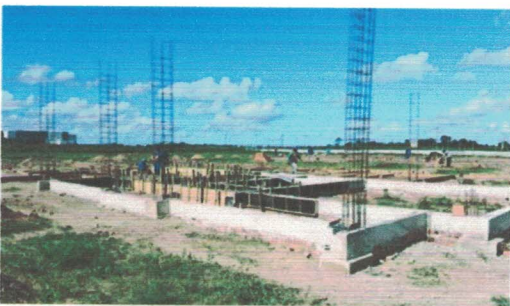
Posicionamento e prumo das armaduras verticais de (-9.7709817, -36.3474868) Data: 18/05/2026
