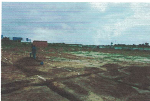
Localização da obra e escavação (-9.7709817, -36.3474868) Data: 15/04/2026
