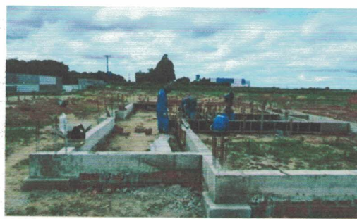
Vigas baldrame concretadas e desformadas. (-9.7709817, -36.3474868) Data: 15/05/2026
