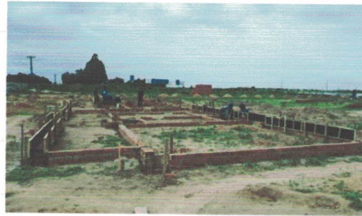
Execução e montagem das formas das vigas (-9.7709817, -36.3474868) Data: 05/05/2026
