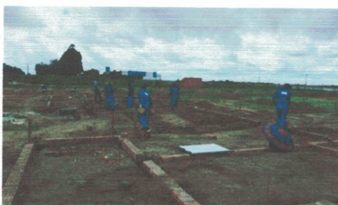
Embasamento da obra. (-9.7709817, -36.3474868) Data: 05/05/2026
