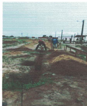
Concretagem das estacas (-9.7709817, -36.3474868) Data: 21/04/2026
