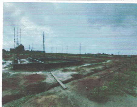
Montagem de formas e alvenaria de embasamento (-9.7709817, -36.3474868) Data: 23/05/2026
