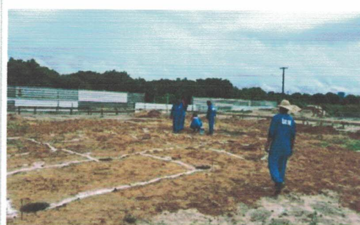
Localização da obra e escavação (-9.7709817, -36.3474868) Data: 14/04/2026
