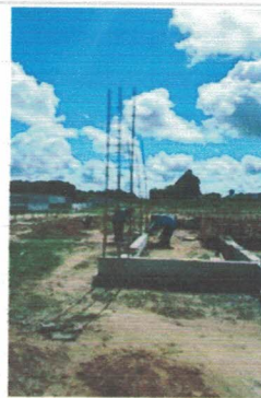
Posicionamento e prumo das armaduras verticais de (-9.7709817, -36.3474868) Data: 16/05/2026
