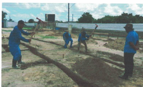
Escavação e concretagem das bases (-9.7709817, -36.3474868) Data: 09/04/2026
