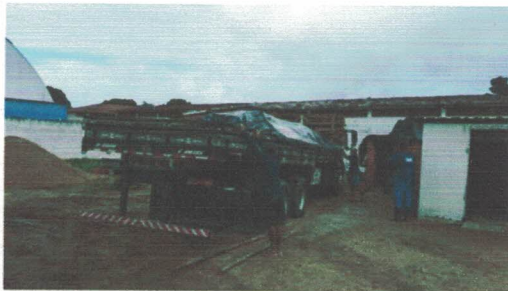
Chegada de material (Cimento) (-9.7709817, -36.3474868) Data: 24/04/2026
