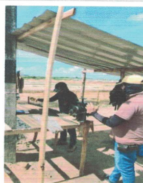
Preparação de vergalhões para armação estrutural (-9.7709817, -36.3474868) Data: 09/04/2026
