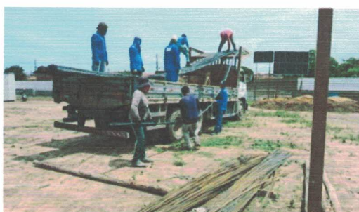
Chegada de material (vergalhão) (-9.7709817, -36.3474868) Data: 15/04/2026
