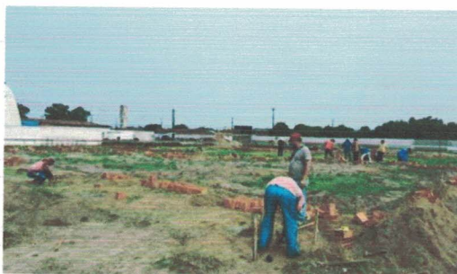
Locação da obra, marcação de gabaritos. (-9.7709817, -36.3474868) Data: 13/05/2026
