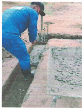
Embasamento da obra (-9.7709817, -36.3474868) Data: 27/04/2026
