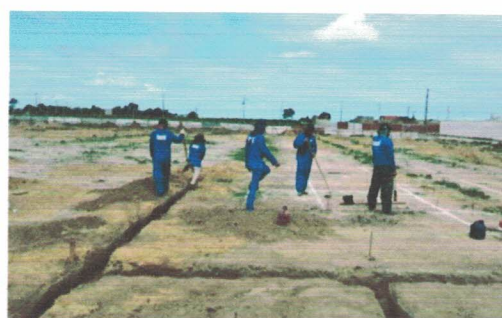
Escavação das bases de fundação (-9.7709817, -36.3474868) Data: 10/04/2026
