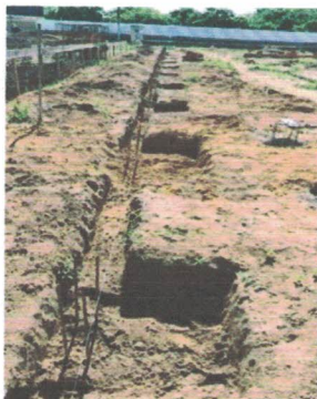
Concretagem das estacas (-9.7709817, -36.3474868) Data: 29/04/2026
