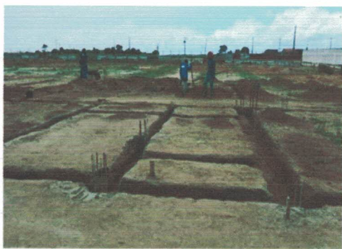
Concretagem das estacas (-9.7709817, -36.3474868) Data: 17/04/2026
