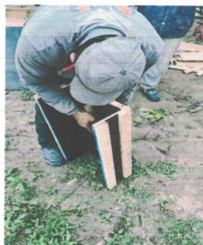
Montagem da caixaria das sapatas (-9.7709817, -36.3474868) Data: 25/04/2026
