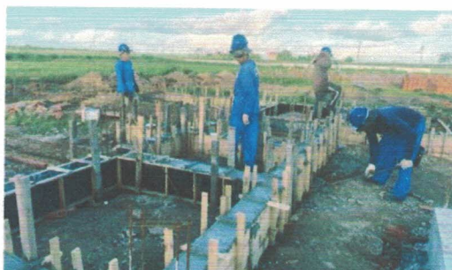
Concretagem das vigas baldrame (-9.7709817, -36.3474868) Data: 27/05/2026
