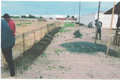
Preparação de vergalhões para armação (-9.7709817, -36.3474868) Data: 10/04/2026
