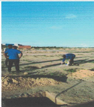
Marcação com cal (-9.7709817, -36.3474868) Data: 06/04/2026
