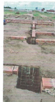
execução parcial das vigas baldrame e montagem (-9.7709817, -36.3474868) Data: 05/05/2026
