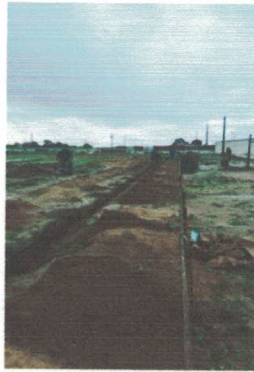
Concretagem das estacas (-9.7709817, -36.3474868) Data: 22/04/2026
