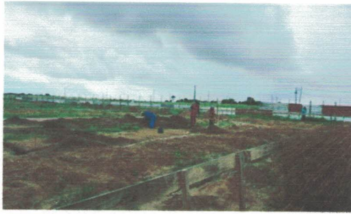
Concretagem das estacas (-9.7709817, -36.3474868) Data: 25/04/2026
