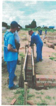
Montagem de formas e conferência de alinhamento (-9.7709817, -36.3474868) Data: 05/05/2026
