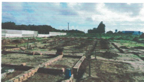
Embasamento da obra (-9.7709817, -36.3474868) Data: 04/05/2026
