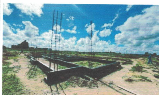
Montagem de formas e alvenaria de embasamento (-9.7709817, -36.3474868) Data: 25/05/2026
