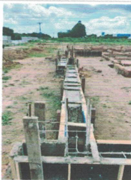
Concretagem de vigas baldrame (-9.7709817, -36.3474868) Data: 12/05/2026
