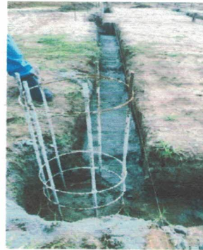
Execução de lastro em concreto magro, com (-9.7709817, -36.3474868) Data: 24/04/2026
