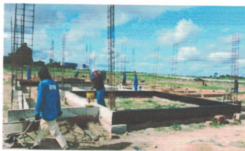
Impermeabilização das vigas baldrame. (-9.7709817, -36.3474868) Data: 22/05/2026
