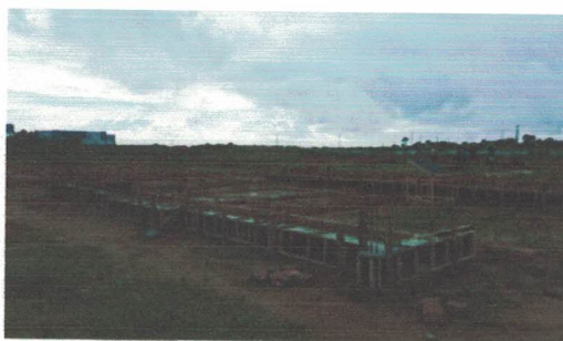
Concretagem de vigas baldrame (-9.7709817, -36.3474868) Data: 12/05/2026
