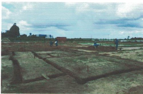
Localização da obra e escavação (-9.7709817, -36.3474868) Data: 13/04/2026
