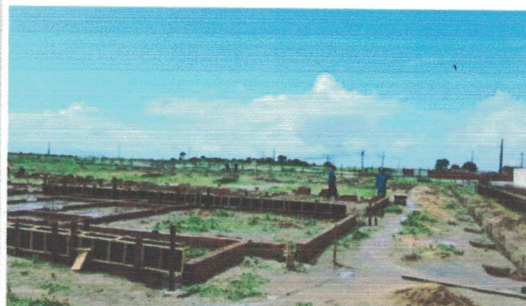
Montagem de formas e alvenaria de embasamento (-9.7709817, -36.3474868) Data: 08/05/2026
