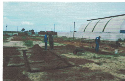
Localização da obra e escavação (-9.7709817, -36.3474868) Data: 15/04/2026
