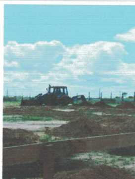
Escavação da fundação. (-9.7709817, -36.3474868) Data: 08/04/2026
