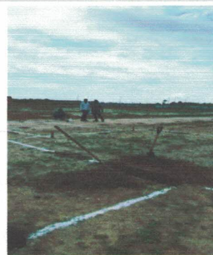
Escavação da fundação (-9.7709817, -36.3474868) Data: 07/04/2026
