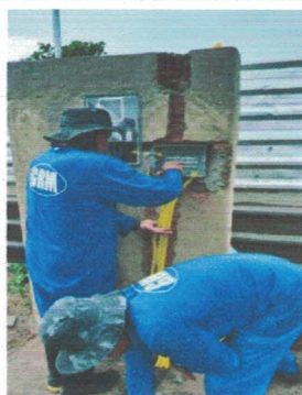
Padrão de energia sendo finalizado (-9.7709817, -36.3474868) Data: 21/04/2026
