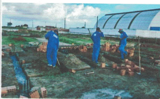
Escavação e regularização do terreno para execução (-9.7709817, -36.3474868) Data: 09/05/2026
