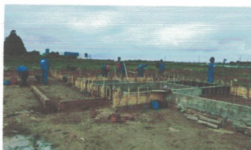
Montagem de formas e alvenaria de embasamento (-9.7709817, -36.3474868) Data: 26/05/2026
