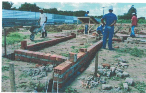
Embasamento da obra (-9.7709817, -36.3474868) Data: 30/04/2026
