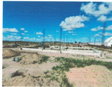
Vigas baldrame concretadas e desformadas. (-9.7709817, -36.3474868) Data: 19/05/2026
