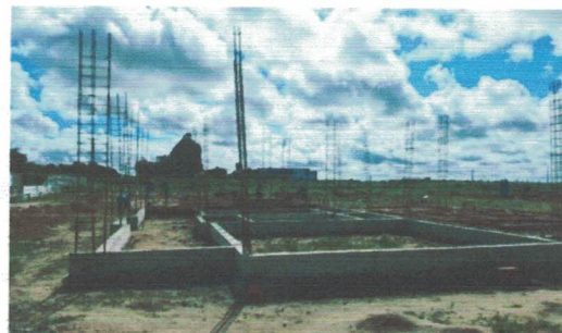
Vigas baldrame concretadas e desformadas. (-9.7709817, -36.3474868) Data: 21/05/2026
