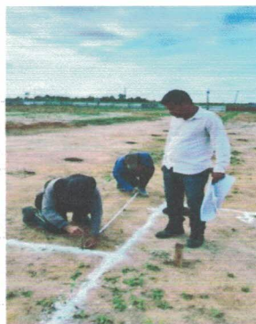
Locação da obra e escavação da fundação (-9.7709817, -36.3474868) Data: 07/04/2026
