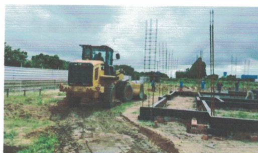
Serviço de aterro (-9.7709817, -36.3474868) Data: 28/05/2026
