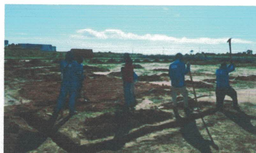
Escavação das bases de fundação (-9.7709817, -36.3474868) Data: 10/04/2026
