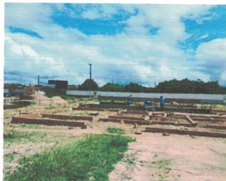
Alvenaria de embasamento concluída em diversos (-9.7709817, -36.3474868) Data: 14/05/2026
