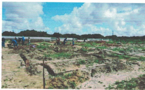
Escavação e regularização do terreno para execução (-9.7709817, -36.3474868) Data: 12/05/2026
