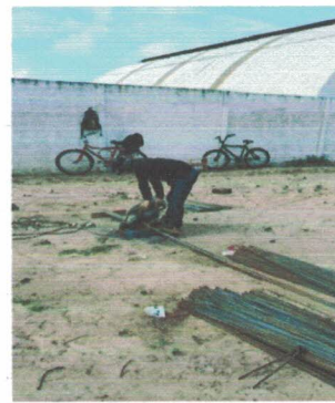
Preparação de vergalhões para armação estrutural (-9.7709817, -36.3474868) Data: 07/04/2026
