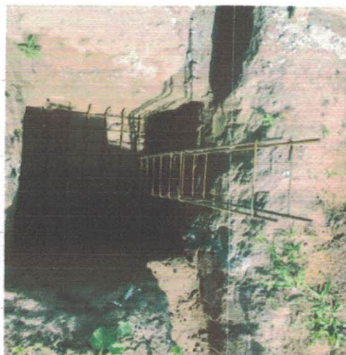
Montagem da caixaria dos arranques (-9.7709817, -36.3474868) Data: 24/04/2026
