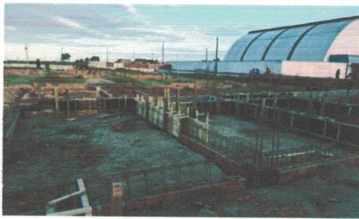
Montagem de formas e alvenaria de embasamento (-9.7709817, -36.3474868) Data: 14/05/2026
