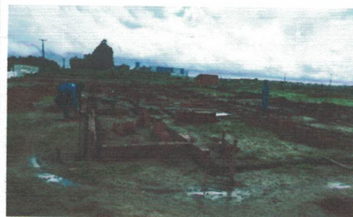
Embasamento da obra (-9.7709817, -36.3474868) Data: 30/04/2026
