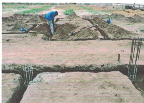
Concretagem das estacas (-9.7709817, -36.3474868) Data: 17/04/2026
