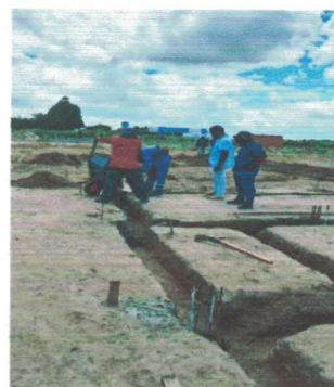
Concretagem das estacas (-9.7709817, -36.3474868) Data: 16/04/2026
