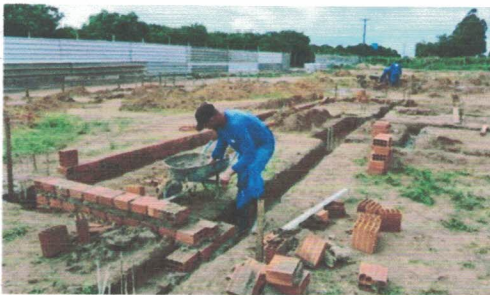
Embasamento da obra (-9.7709817, -36.3474868) Data: 28/04/2026
