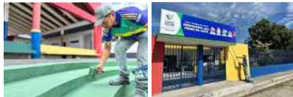
Serviços de manutenção nas unidades de ensino
