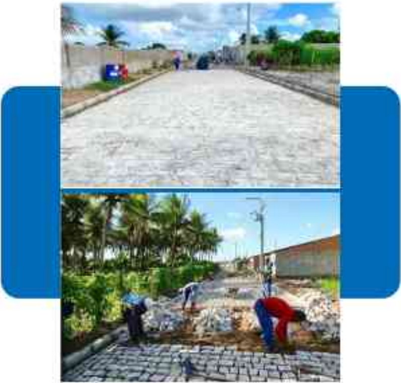
Pavimentação de ruas na Sede do Município e no Distrito de Luziápolis.
