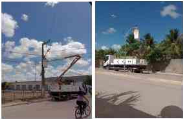
Manutenção do sistema de Iluminação Pública
