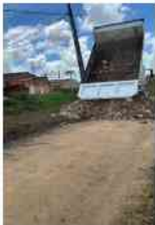
Terraplanagem em ruas do município
