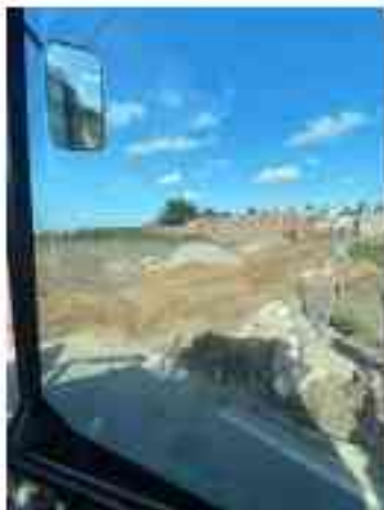
Terraplanagem em zona rural
