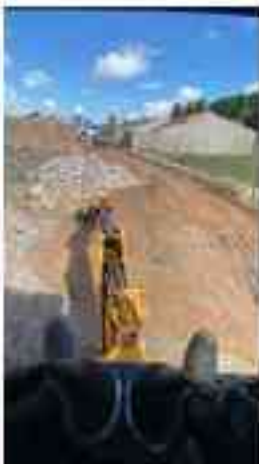
Terraplanagem em ruas do município
