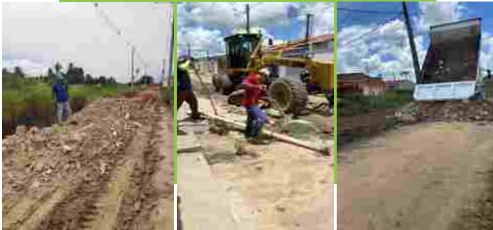
Terraplanagem em zona rural
