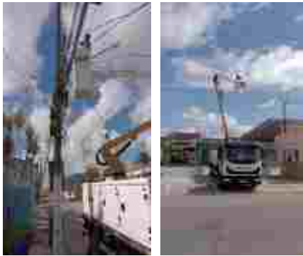
Manutenção do sistema de Iluminação Pública
